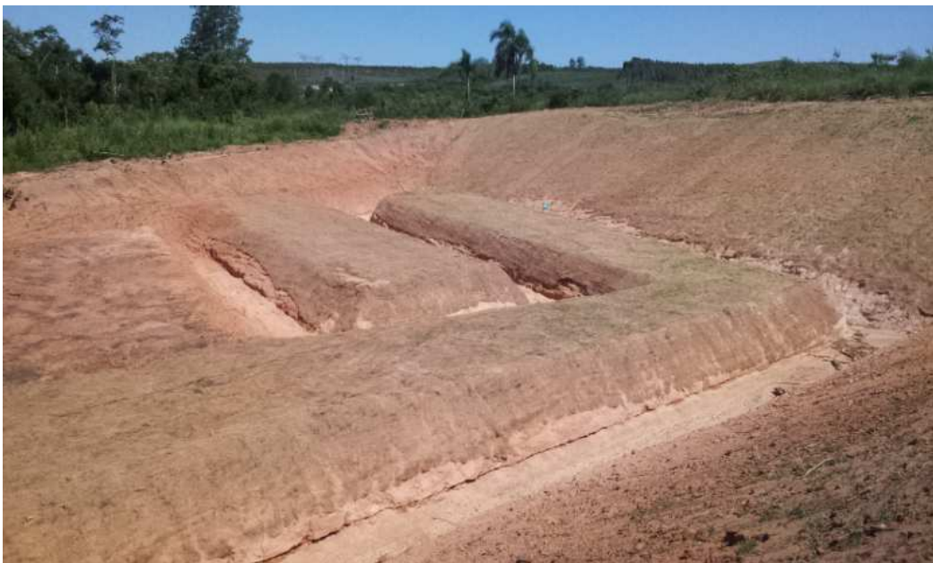
Foto 3: Polimento final do tratamento de efluentes
